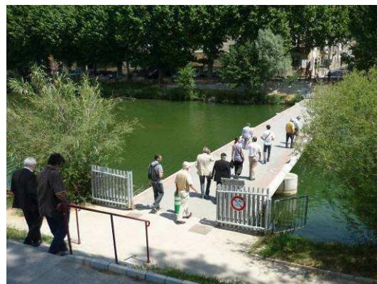
Passerelle piétonne submersible
