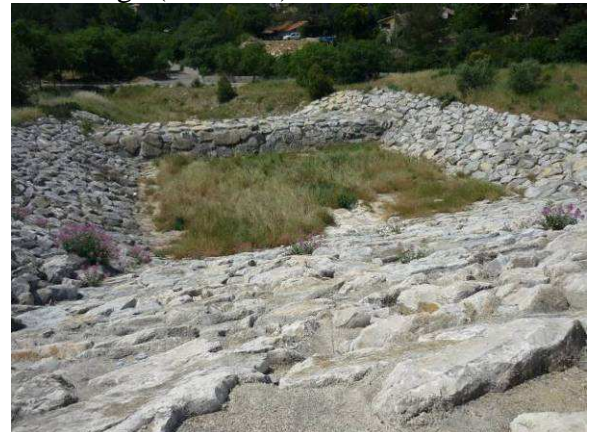
Ci- dessus : bassin de dissipation de l'énergie
