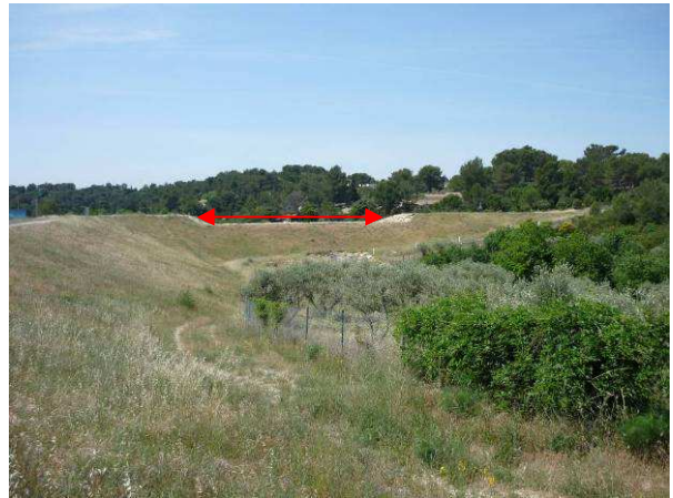
Vue de la longueur du déversoir de crues
