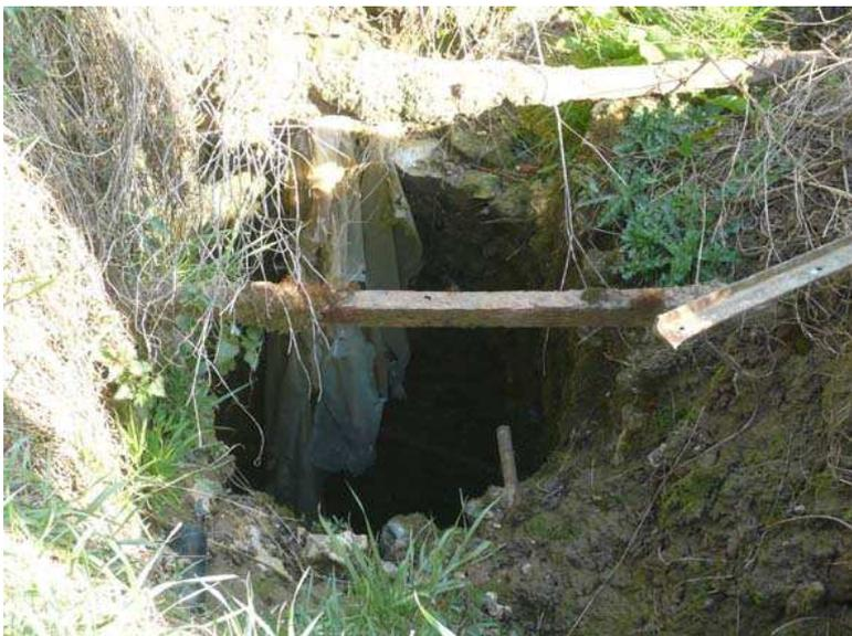
Un puit maçonné a été aménagé dans le fond de la bétoire. Les hommes ont cherché, il y a longtemps, à évacuer les eaux stagnantes (issues des ruissellements sur les versants) en creusant une sorte de puit d'infiltration pérenne, au dessus de la bétoire, afin qu'elle évite de fonctionner comme sur le site n°1. Avec ce type d'aménagement, les risques de pollution de nappes sont énormes !
