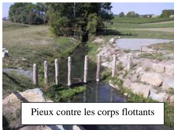
A l'amont de la digue, des pieux en bois sont plantés dans le lit de la rivière. Ils servent de protection contre des corps flottants encombrants qui pourraient venir obstruer les vannes.
