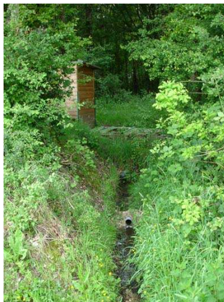
Fossé de reprise et station de mesure à l'aval du bois
