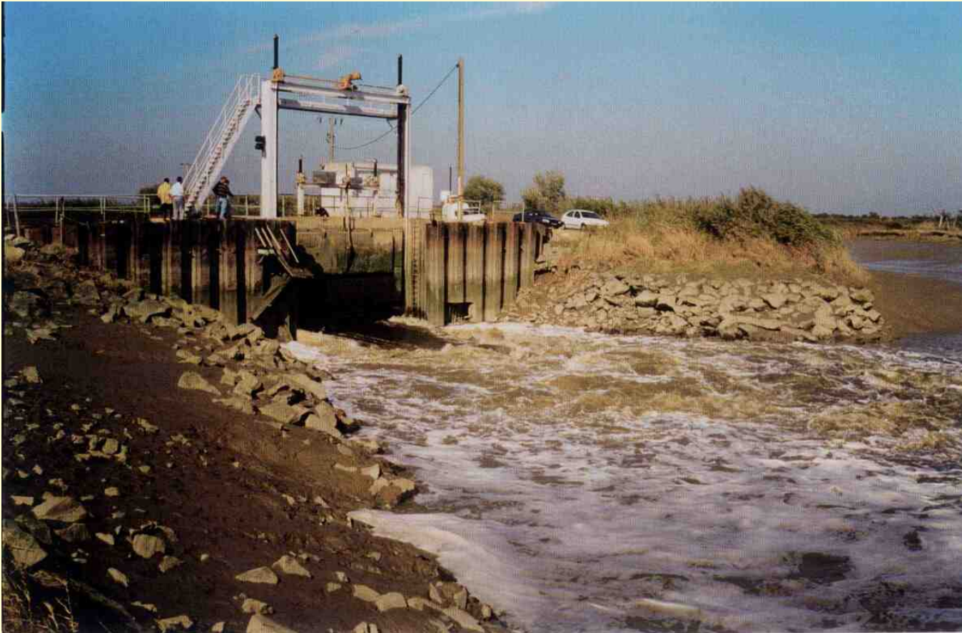
Vannage de LAVAU (44) Vue général aval
