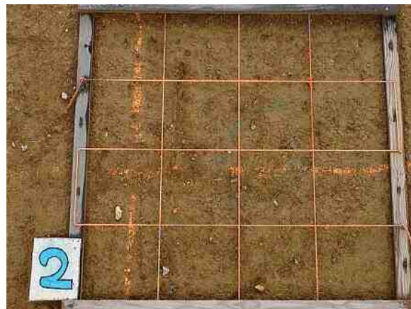
Talus digue en limon traité
