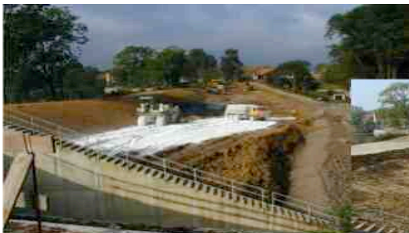
République Tchèque : reconstruction de la digue sèche de Hvezda en 2003 suite à une rupture provoquée par des inondations
