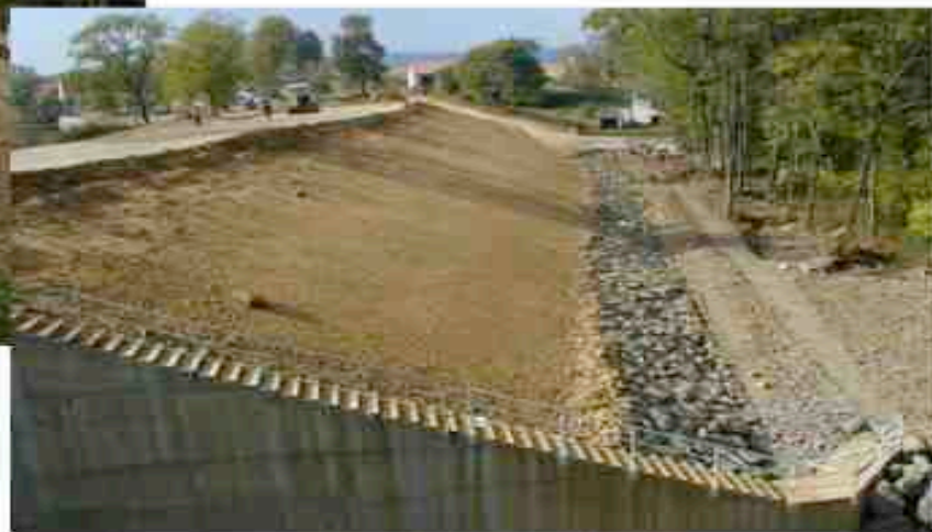
République Tchèque : reconstruction de la digue sèche de Hvezda en 2003 suite à une rupture provoquée par des inondations
