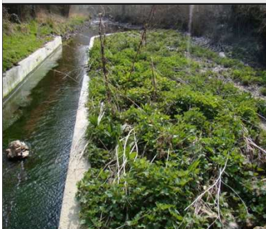
Section de l'Iton aménagée par un auget : prise de vue sur l'entrée de l'Iton dans l'auget
