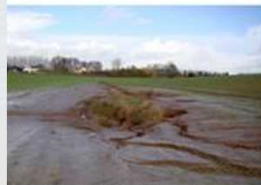
line bétoire n°8098 : observation de ravissements et de ruissellements s'engouffrant dans la bétoire (observation BRGM du 27/11/2009)
