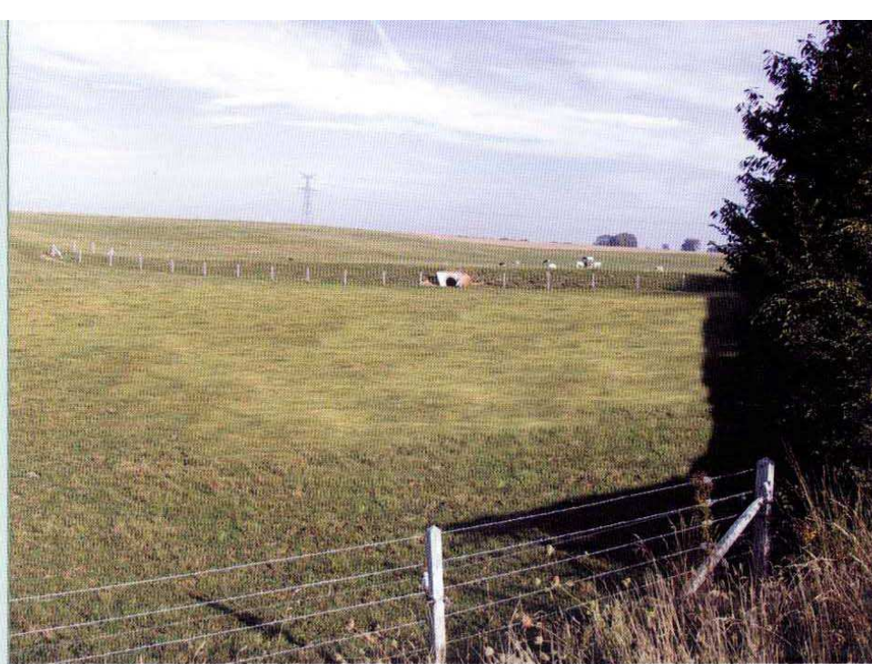
PRAIRIE INONDABLE RÉALISÉE PAR LA DDI LE LONG DE LA DÉVIATION DE MONTVILLIERS
