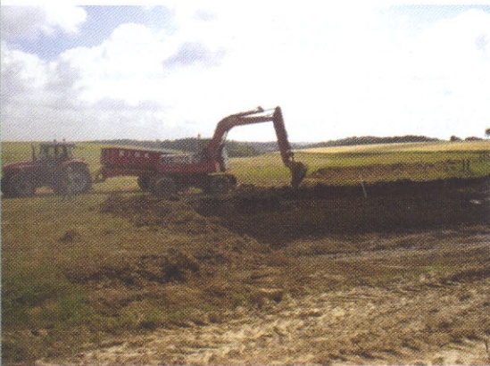
TRAVAUX DE TERRASSEMENT D'UNE MARE À ST-MARTIN-OSMONVILLE
