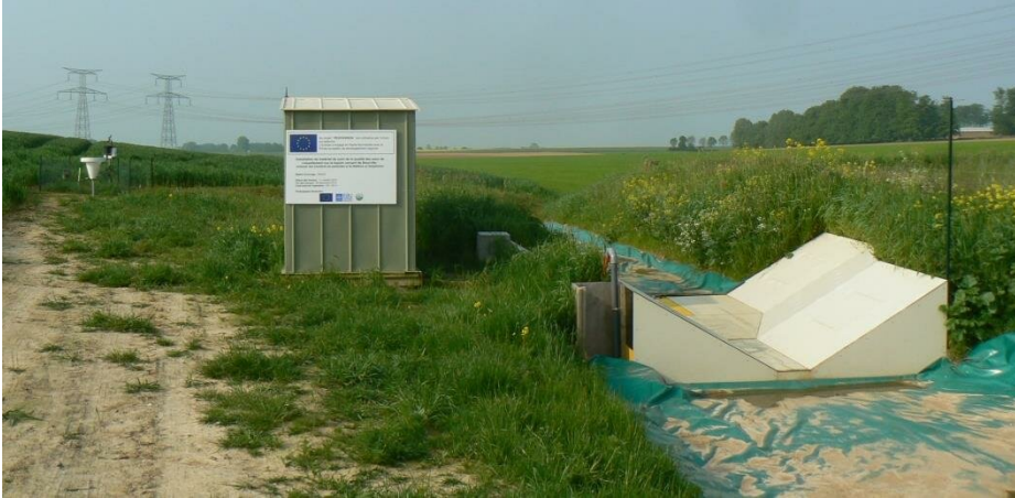
Figure 8 : le site de mesures de FDTL, vu de l'aval
