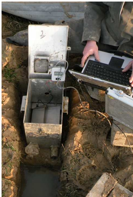
Figure 4 - Auget basculeur avec enregistreur et fosse de sortie en aval
