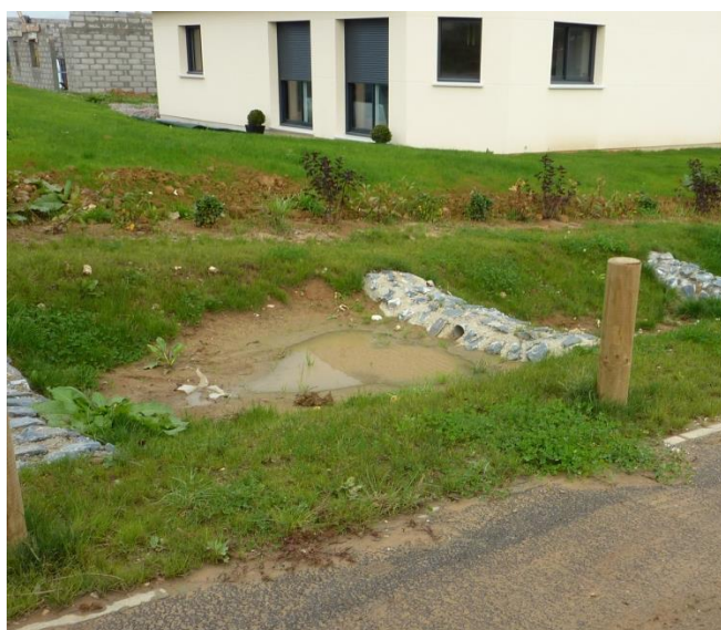
Figure 58 : dépôt de limon dans une noue lors de travaux de construction de maisons dans un lotissement neuf
