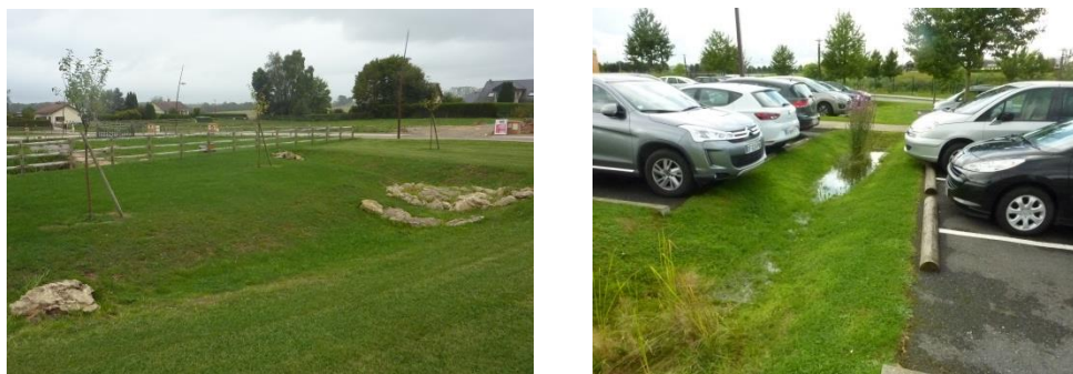
Figure 11 : Noues de transfert des eaux pluviales vers un bassin
