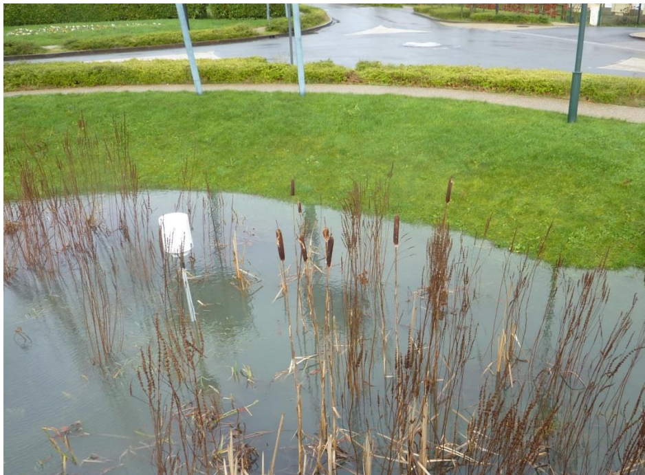
Figure 30 : Bassin instrumenté en cours de vidange par infiltration (bassin d'Allouville-Bellefosse)
