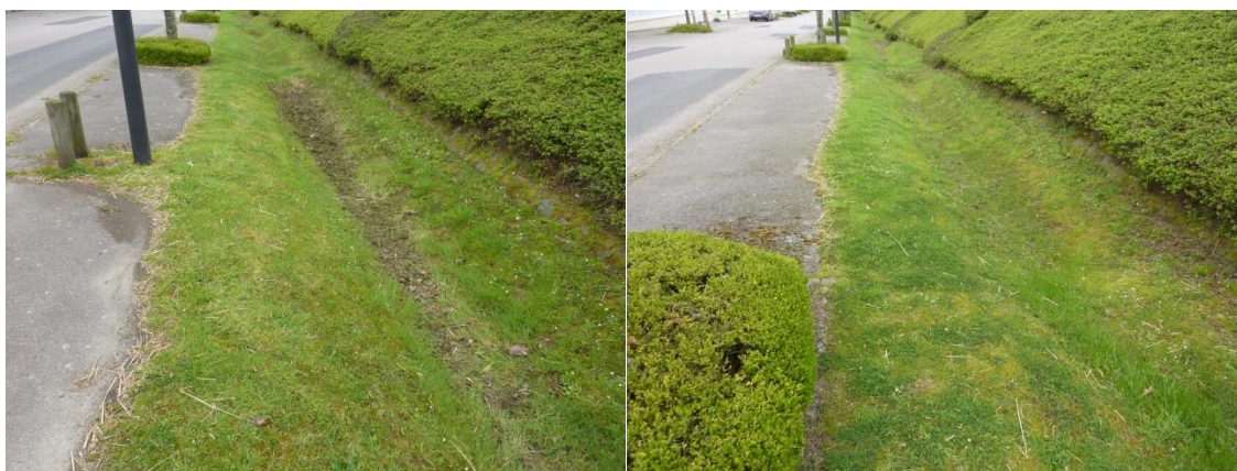
Figure 37 : Noue 3 (à gauche) et noue 4 (à droite) à Saint-Jean-de-Folleville
