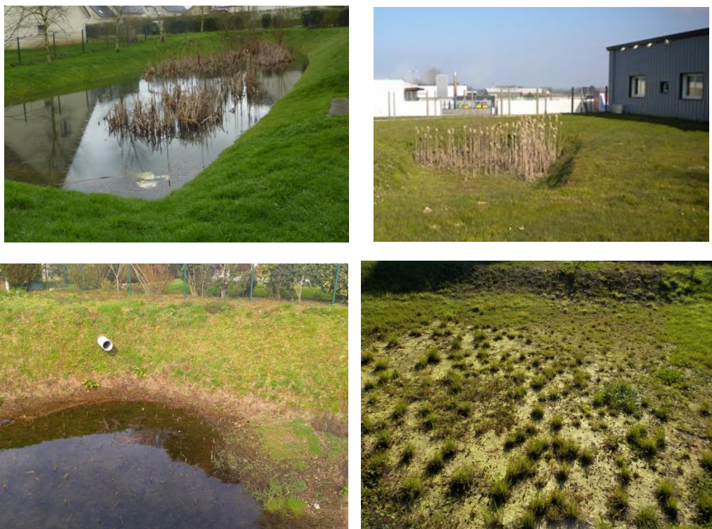
Figure 55 : Exemples d'aménagements avec un temps de séjour élevé, en lien avec une disparition de la végétation herbacée, et un développement de végétation de zone humide, voire un colmatage de la surface d'infiltration
