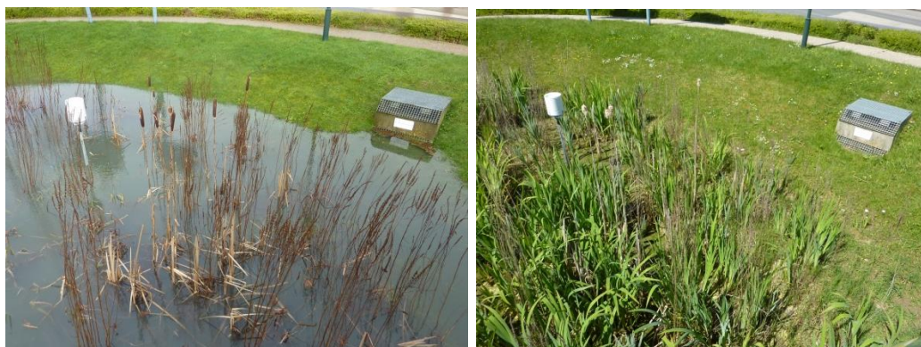
Figure 2 : bassin qui se vidange par infiltration pour les petites pluies puis par rejet à débit régulé lorsque la hauteur d'eau dépasse 30cm
