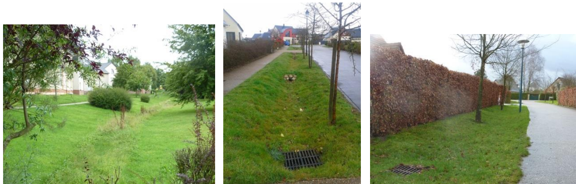
Figure 3 : Noues de transfert
