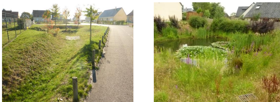
Figure 13 : a) Espace vert creux intégré dans l'espace public – b) Mare tampon collectant les eaux de surverse
