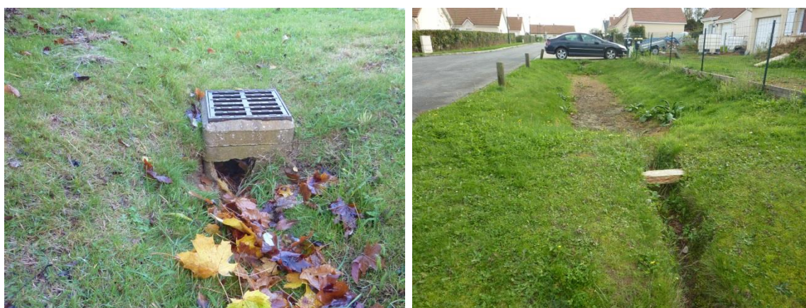
Figure 60 : Exemples de noues d'infiltration « court-circuitées »
