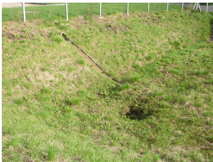
Figure 47 : Exemple de cavité en entrée d'un bassin de gestion des eaux pluviales centralisé
