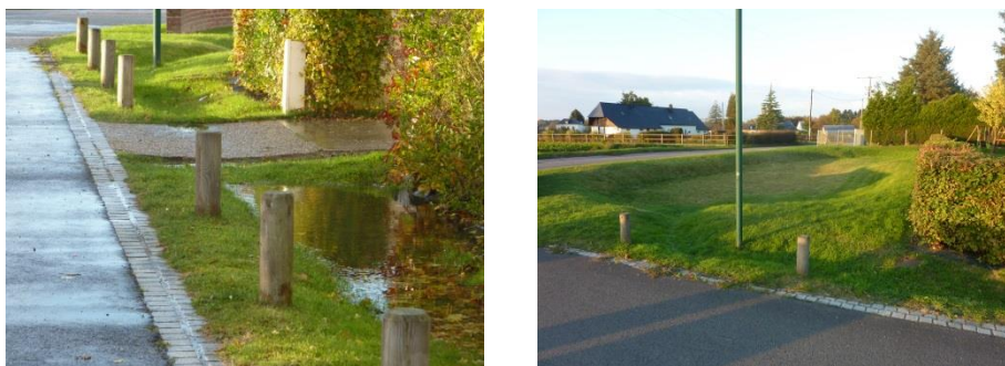
Figure 12 : Noues d'infiltration avec bassin en aval
