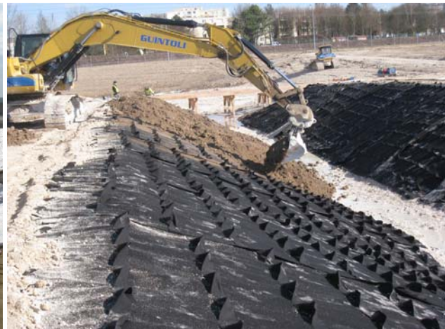
Géoconteneur et terre végétale sur les berges de la rivière artificielle (Mars 10)
