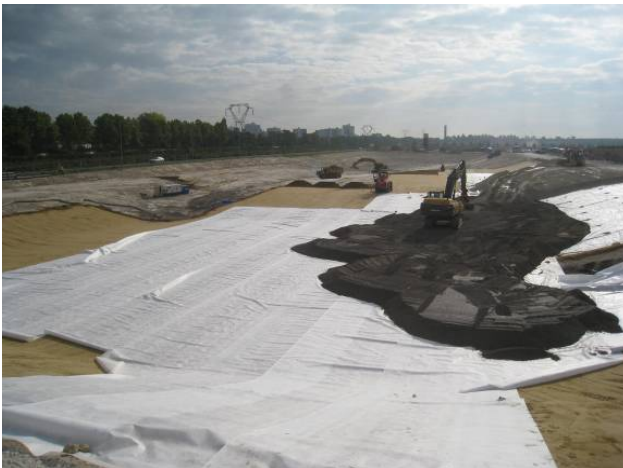
Etanchéité et lestage (Oct. 09)
