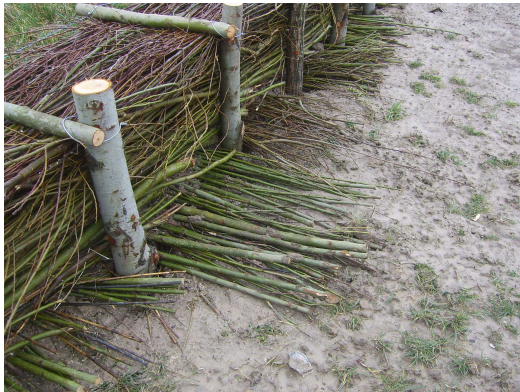
Photo 3 : Essai de mise en place de branches de saule sur le sol pour faciliter leur reprise Exemple sur le bassin versant de l'Yères
