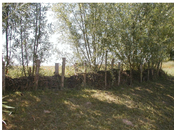
Photo 1 : Fascine avec pieux vivants (Photo SMBV du Dun et de la Veules)
