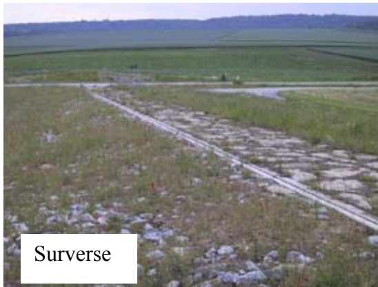
Détail de la surverse : la barre en béton
