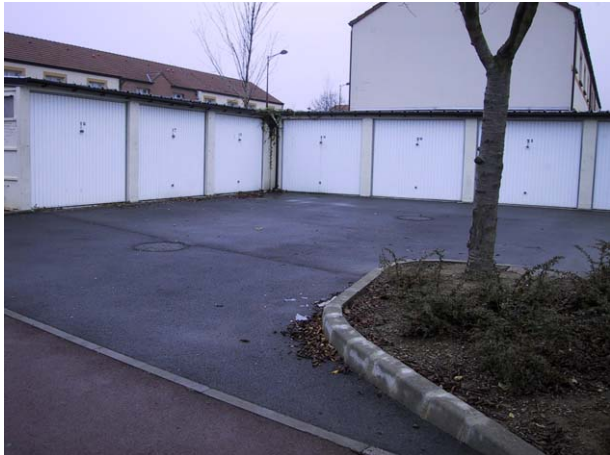
Ensemble de garages et cour dont les eaux sont récupérées par trois puits d'infiltration
