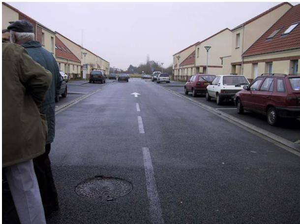
Chaussée bordée de caniveaux et de bouches
