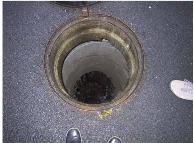
Puits d'infiltration
