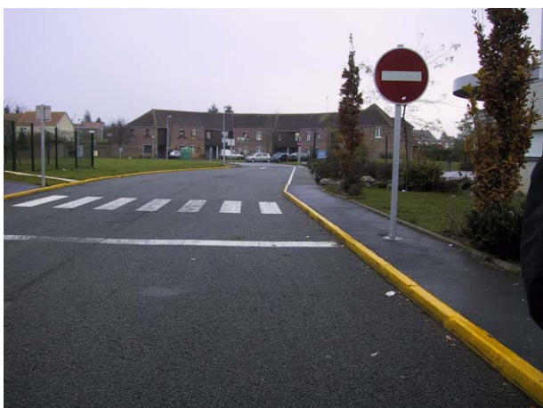
Aucune bouche d'égout le long d'une chaussée avec enrobé poreux
