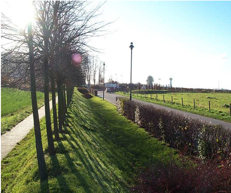
Voirie bordée de fossés de stockage en cascade (avec brise jet en moellons)
